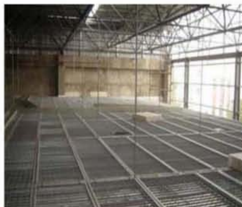
组合式钢结构停车楼
